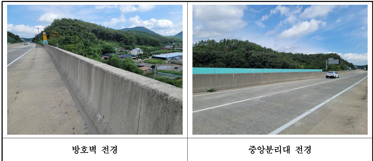
【사진 39.3.23】 방호벽 및 중앙분리대 전경
