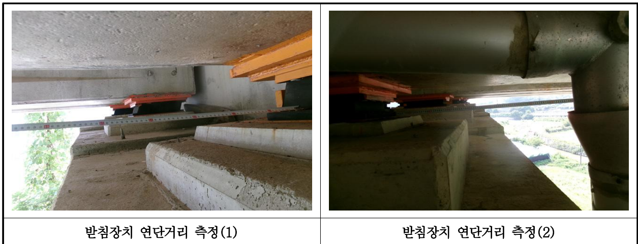
【사진 39.3.14】 교량받침장치 연단거리측정
