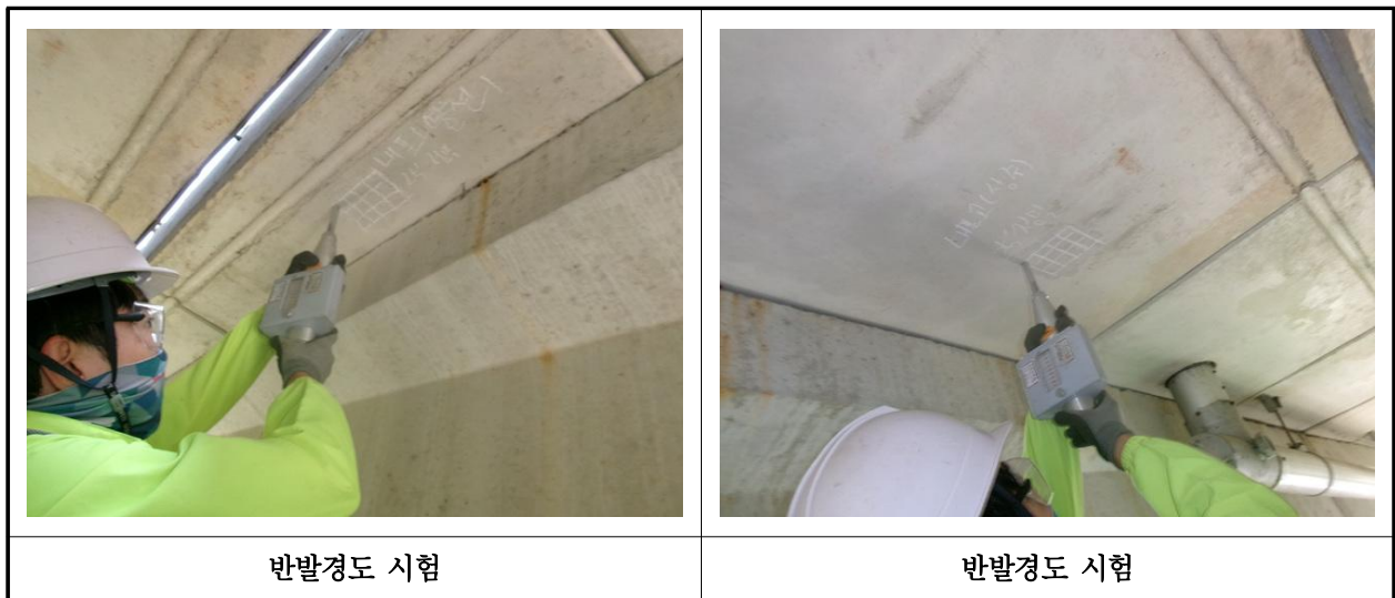
【사진 39.4.2】 반발경도시험 현장사진
