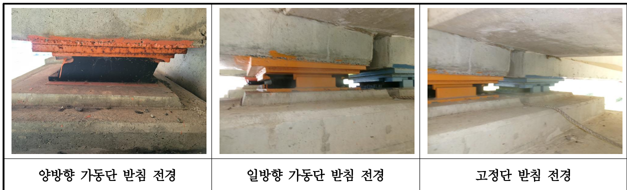
【사진 39.3.12】 교량받침 전경
