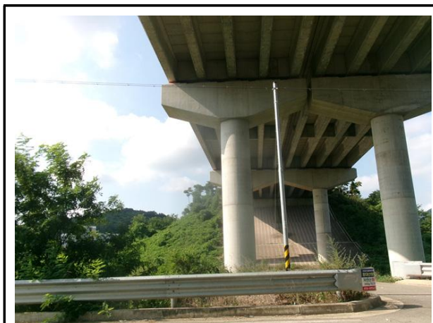
하부 교차 시설 전경
