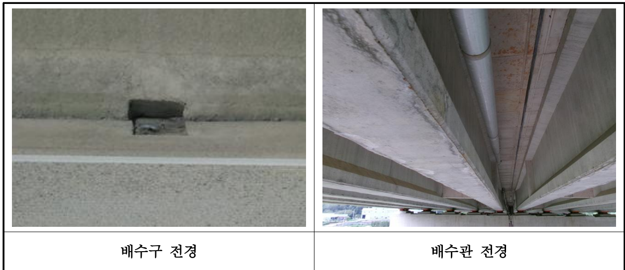
【사진 39.3.21】 배수시설 전경
