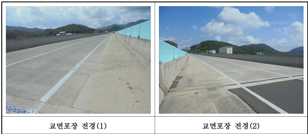
【사진 39.3.44】 교면포장 전경
