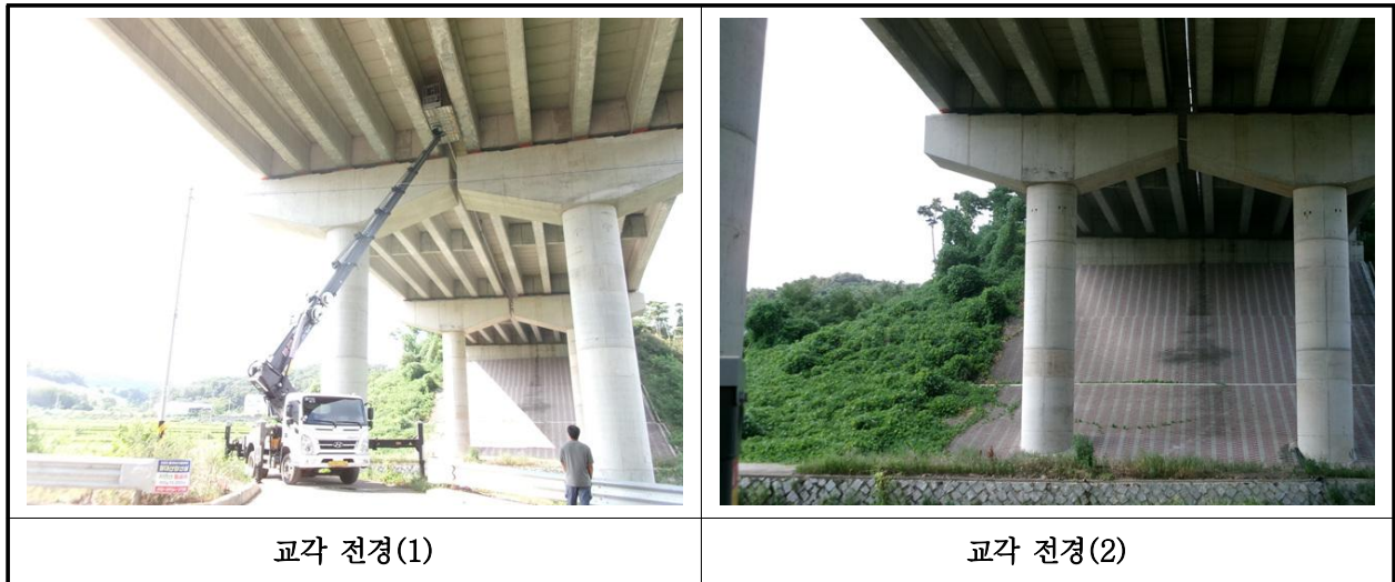
【사진 39.3.10】 교각 전경
