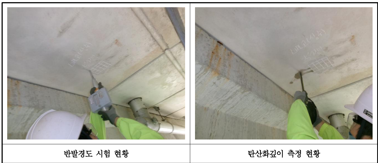
【사진 39.4.1】 콘크리트 내구성조사 현황
