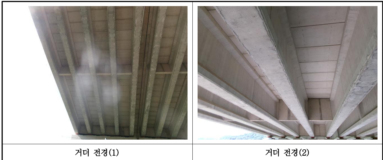
【사진 39.3.4】 거더 전경
