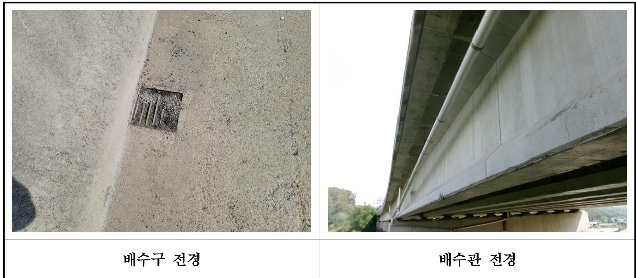
【사진 39.3.46】 배수시설 전경
