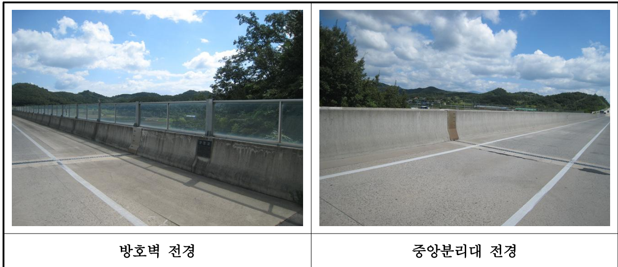
【사진 39.3.48】 방호벽 및 중앙분리대 전경
