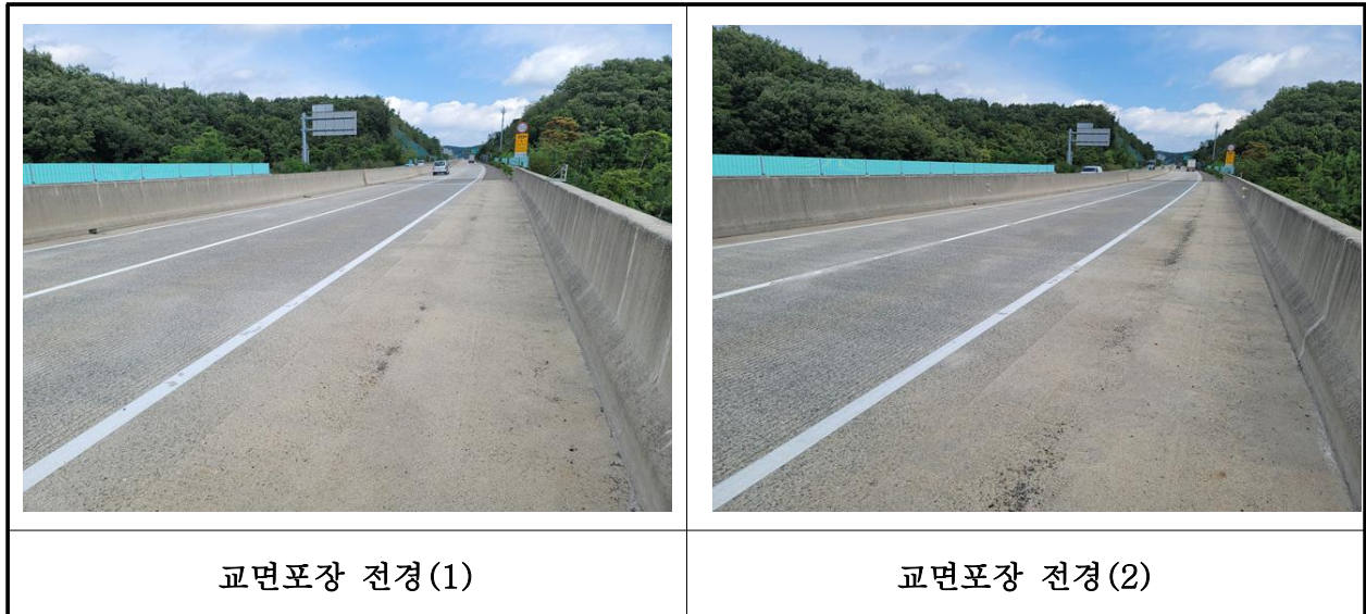
【사진 39.3.19】 교면포장 전경
