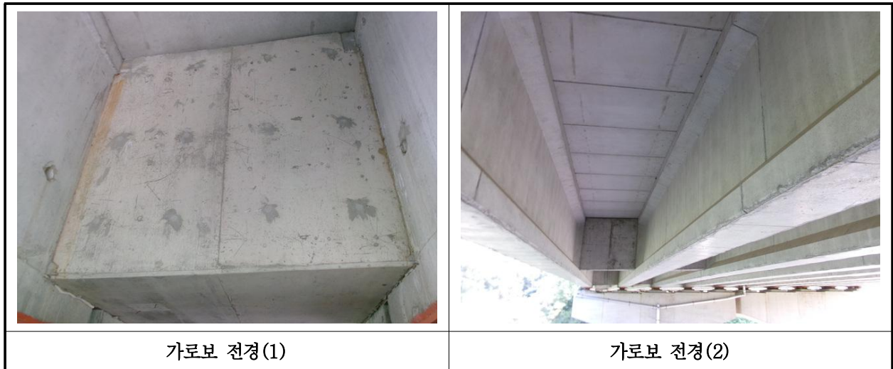
【사진 39.3.31】 가로보 전경
