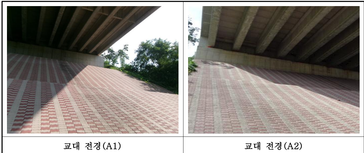
【사진 39.3.8】 교대 전경
