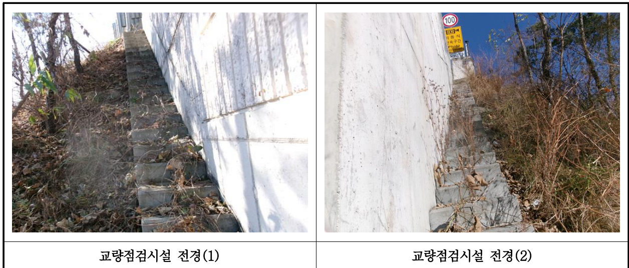
【사진 39.3.50】 교량 점검시설 전경
