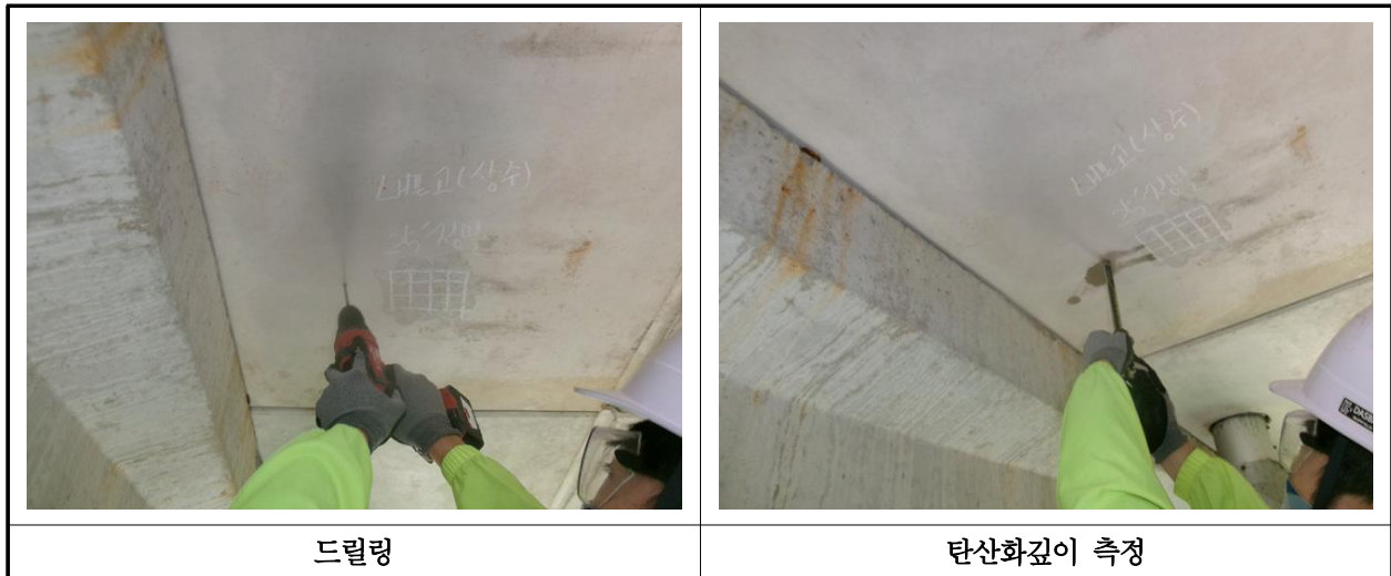
【사진 39.4.3】 탄산화 깊이 측정 현장사진
