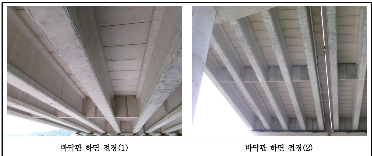
【사진 39.3.2】 바닥판하면 전경
