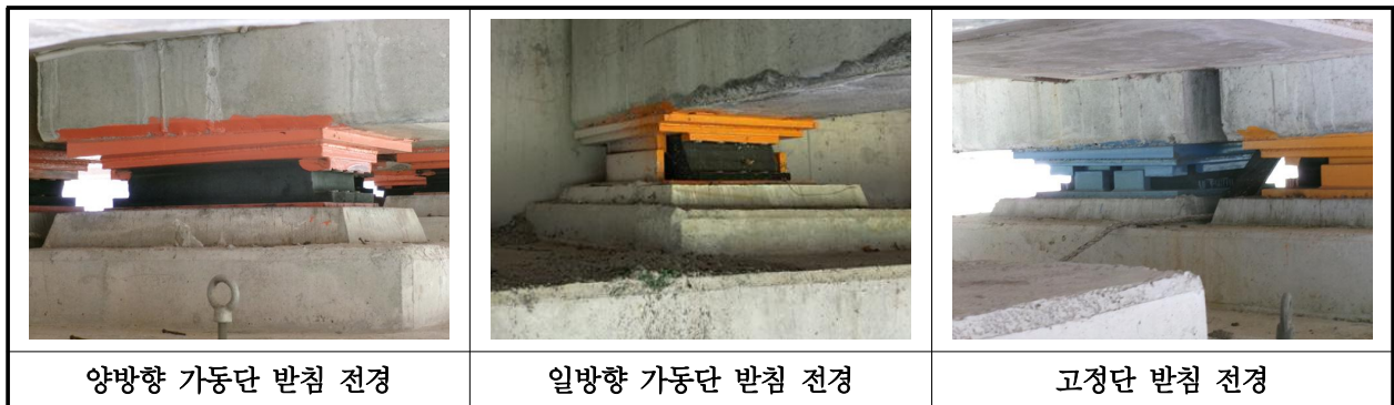
【사진 39.3.37】 교량받침 전경
